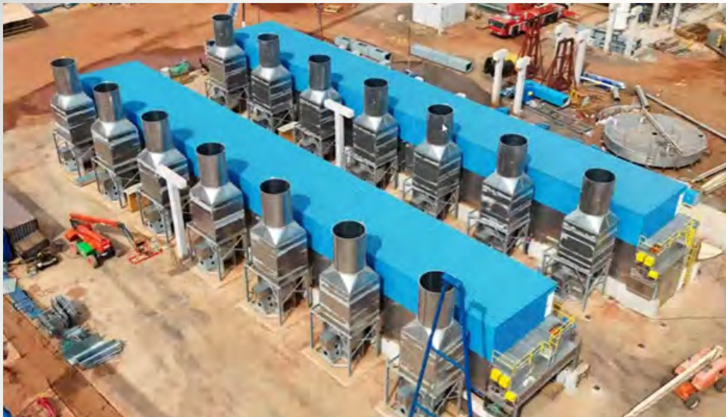
项目地：Suzano Papel e Celulose, 巴西 | 型号：2x BT 1/6200-51 | 安装年份：2022 干燥物料：桉树皮 | 出料能力：约2x 15.7吨/小时 | 降水区间：45% - 5%湿度
