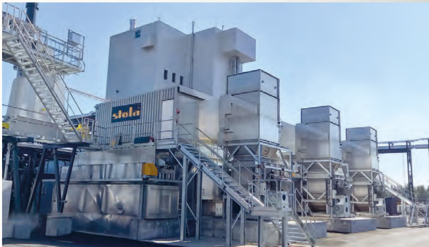
项目地：Pyrocell, 瑞典 | 型号：BTU 1/6200-27-3 | 安装年份：2021 干燥物料：木屑、木片 | 出料能力：约6.0吨/小时 | 降水区间：55% - 3%湿度
