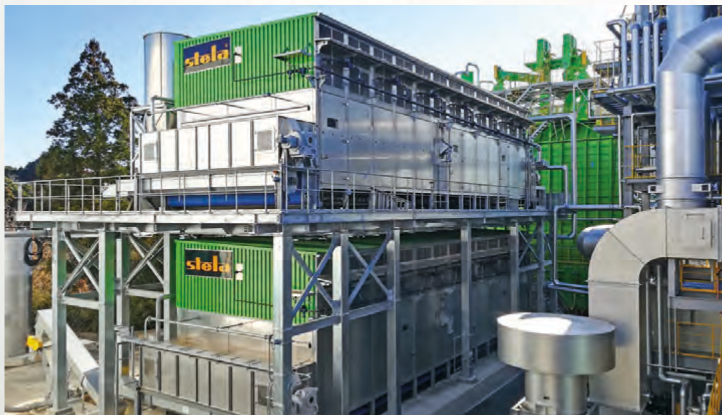
项目地：东京板业, 日本 | 型号：2x BT 1/6200-19.5 | 安装年份：2017 干燥物料：碎木片、木屑 | 出料能力：约2x 8.0吨/小时 | 降水区间：100% - 2%含水率
