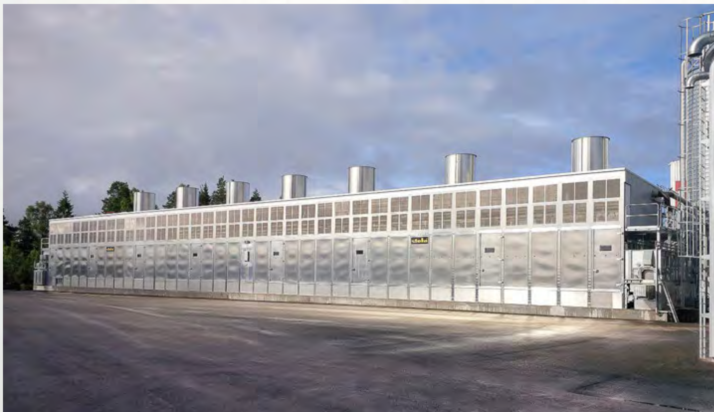
项目地：Uddevalla Energi, 瑞典 | 型号：BT 1/6200-55.5 | 安装年份：2015 干燥物料：木屑 | 出料能力：约13.0吨/小时 | 降水区间：55% - 8%湿度
