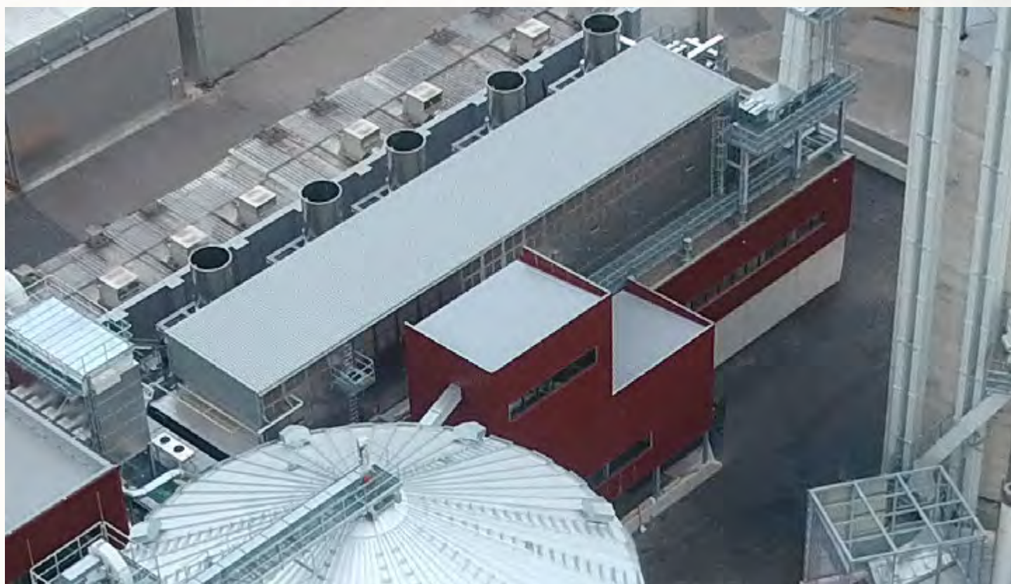
项目地：Donausäge Rumplmayr, 奥地利 | 型号：BT 1/6200-34.5 | 安装年份：2022 干燥物料a：木屑 | 出料能力：约8.0吨/小时 | 降水区间：50% - 10%湿度
