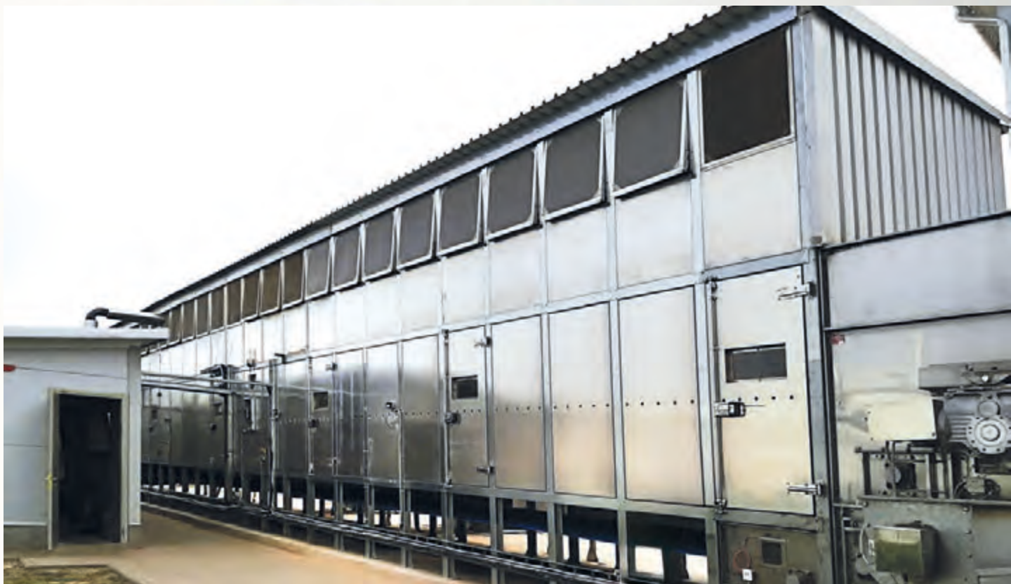
项目地：Postavsky Mebelny, 白俄罗斯 | 型号：BT 1/2700-16扩展至BT 1/2700-24 | 安装年份：2018 干燥物料：木屑 | 出料能力：约3.3吨/小时 | 降水区间：55% - 10%湿度
