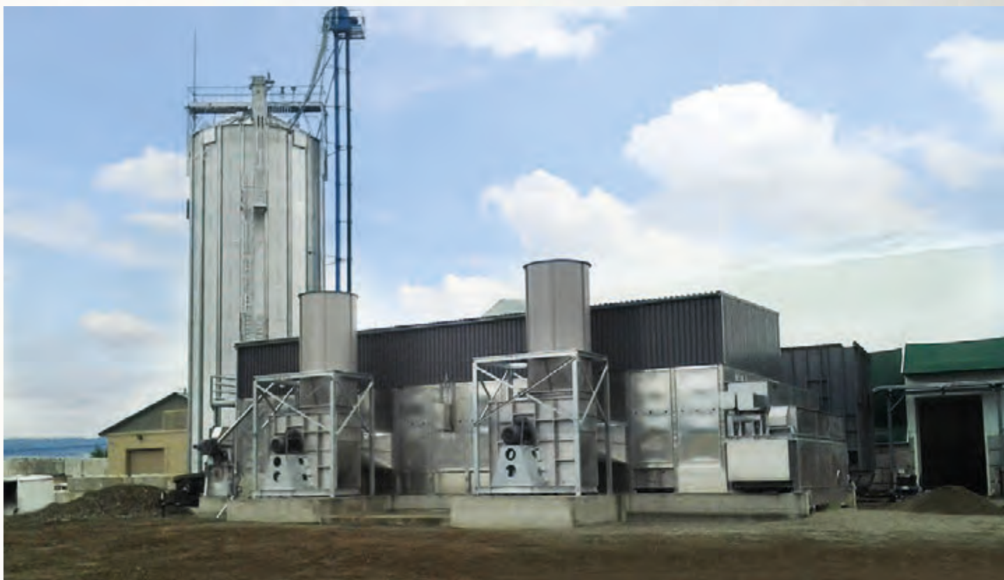
项目地：Diacarbon Energy, 加拿大 | 型号：BT 1/6200-19.5 | 安装年份：2014 干燥物料：木屑 | 出料能力：约5.56吨/小时 | 降水区间：50% - 10%湿度
