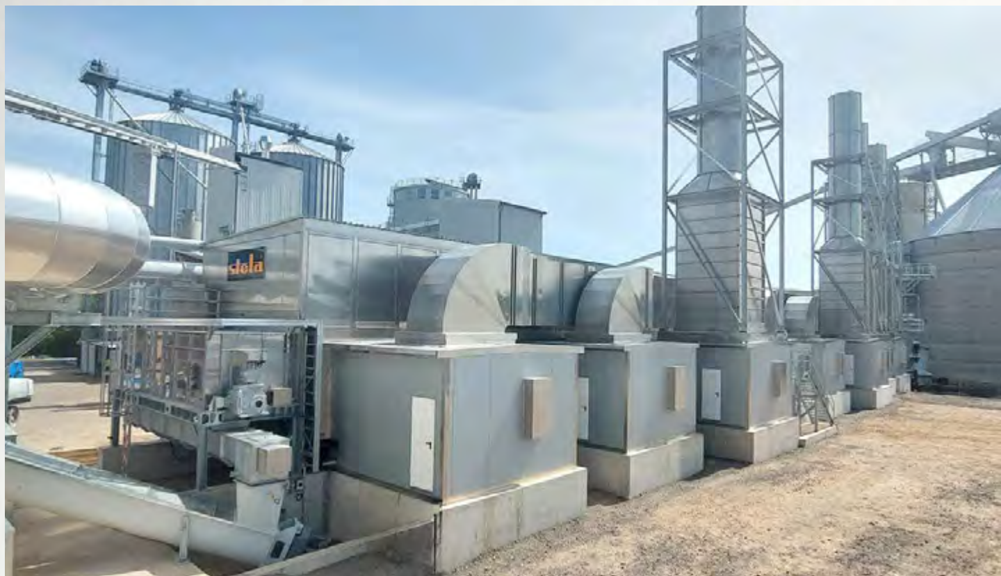
项目地: Ante-holz Rottleberode GmbH, 德国 | 型号: BTU 1/6200-60 | 安装年份: 2023 干燥物料: 木屑 | 出料能力: 18.6 吨/小时 | 降水区间: 48% - 10%湿度
