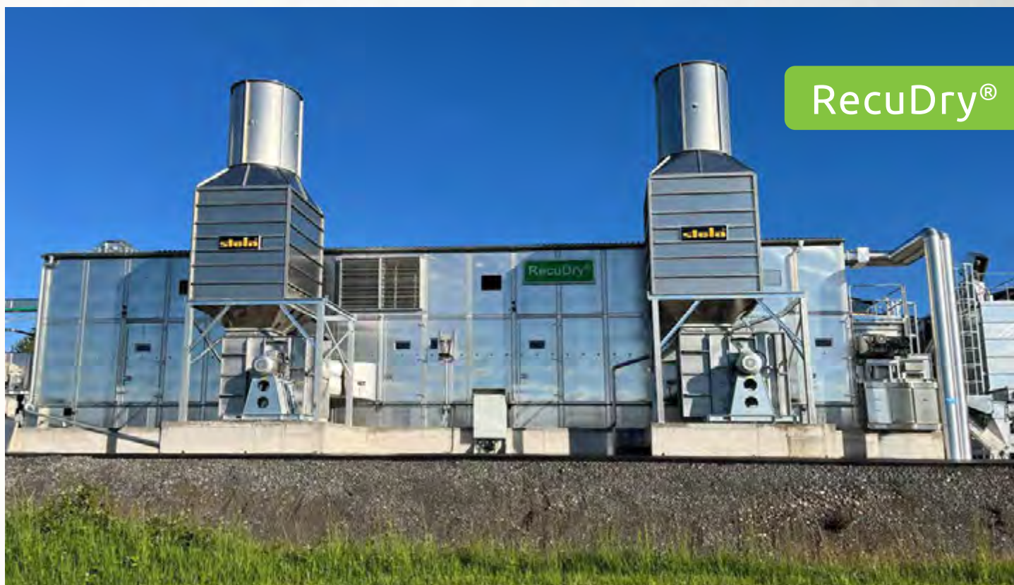
项目地：Weinsberg Pellets, 奥地利 | 型号：BTU RecuDry 1/6200-27 | 安装年份：2023 干燥物料：木屑 | 出料能力：约7.5吨/小时 | 降水区间：50% - 10%湿度
