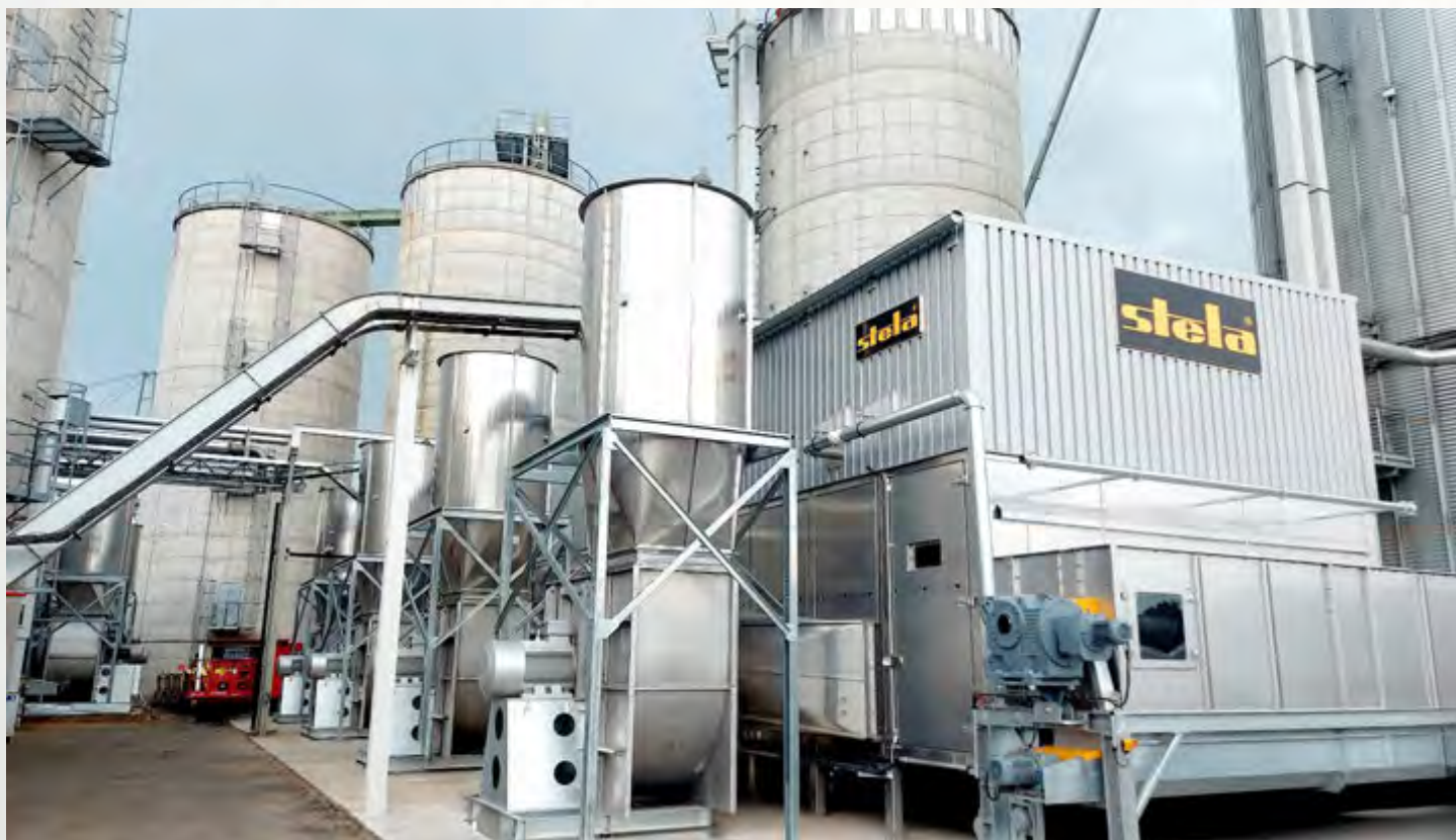
项目地：GDM Peletts S.A.S, 法国 | 型号：BT 1/6200-31.5 | 安装年份：2023 干燥物料：木屑 | 出料能力：约10.5吨/小时 | 降水区间：50% - 10%湿度
