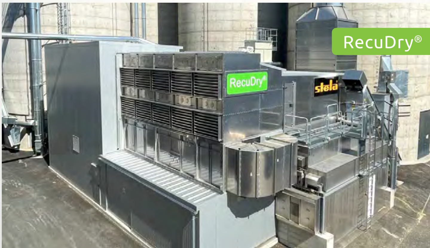
项目地：FM Holzstrom GmbH, 奥地利 | 型号：BTU RecuDry 1/6200-16.5 | 安装年份：2022 干燥物料：木屑 | 出料能力：约6.3吨/小时 | 降水区间：42% - 10%湿度
