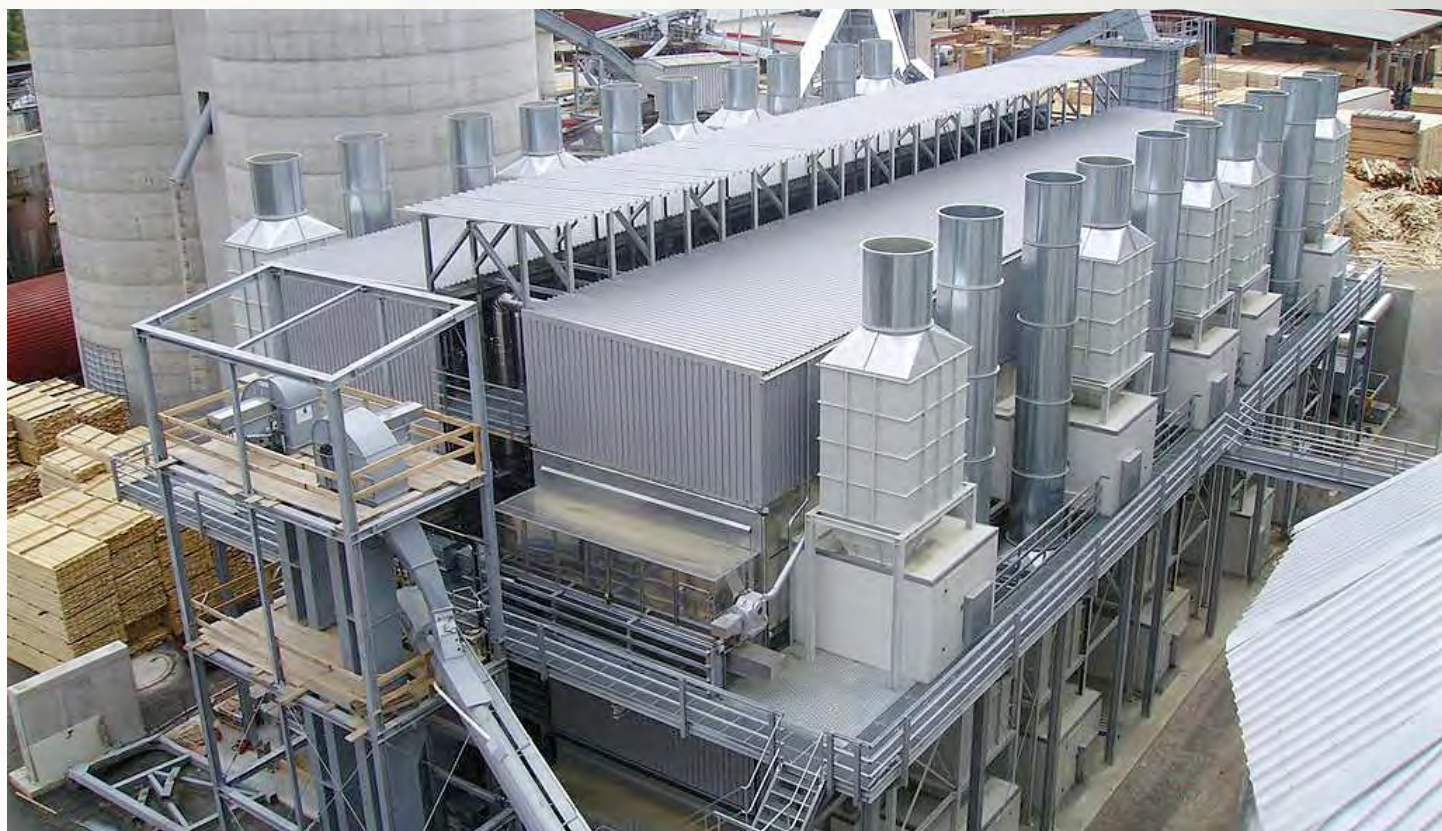
项目地：Pfeifer Holz GmbH, 德国 | 型号：4x BT 1/6200-36 | 安装年份：2007 干燥物料：木屑 | 出料能力：约50.0吨/小时 | 降水区间：50% - 3%湿度
