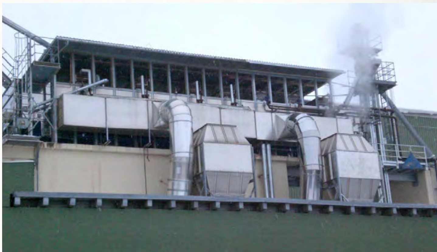
项目地：Bayerwald Pellet, 德国 | 型号：BT 1/2700-10 扩展至 BT 1/2700-16 | 安装年份：2009 干燥物料：木屑 | 出料能力：约2.1吨/小时 | 降水区间：50% - 10%湿度
