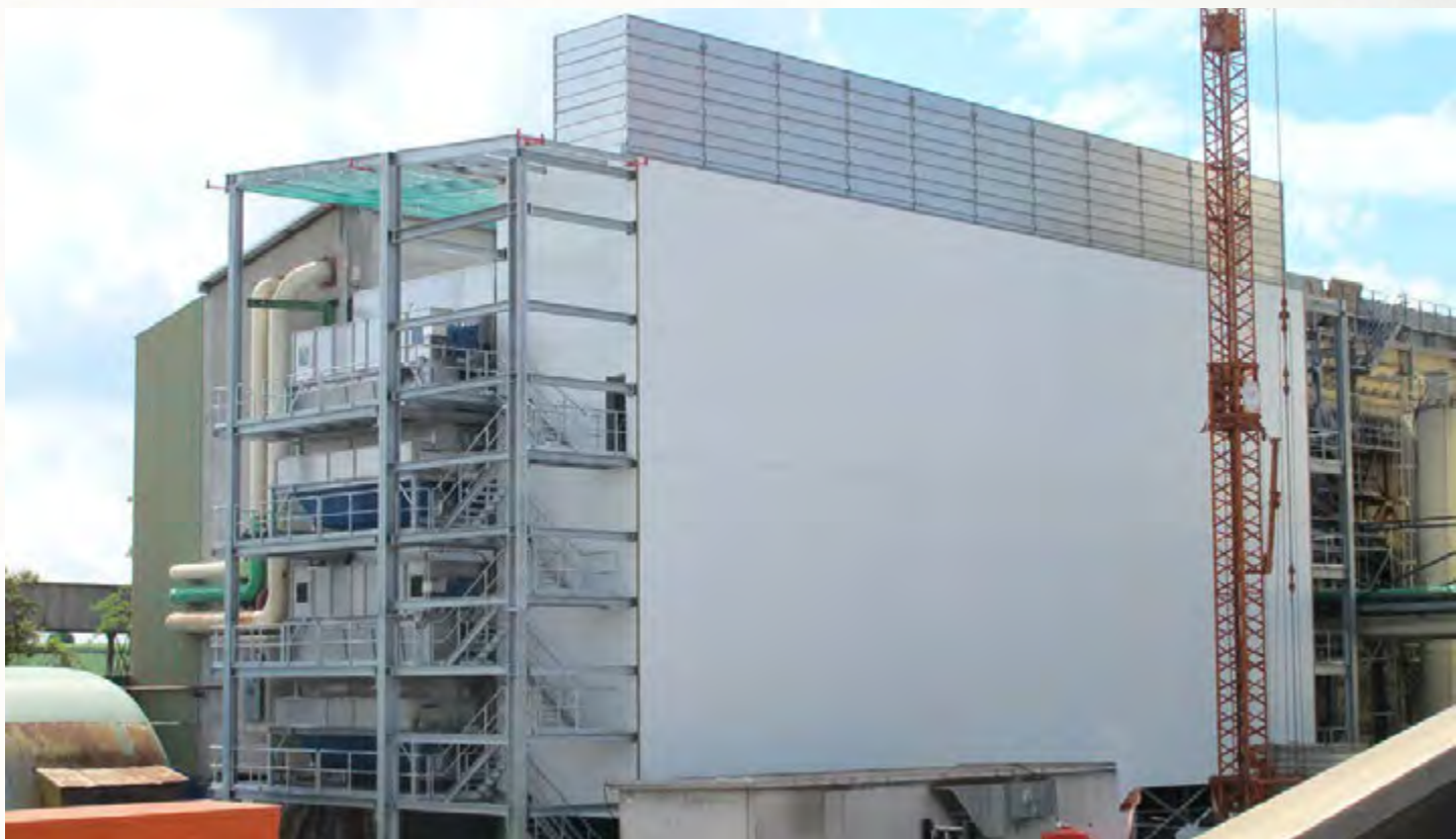
项目地：德国 | 型号：BT 4/6200-30 | 安装年份：2014 干燥物料：甜菜渣 | 出料能力：约96.0吨/小时 | 降水区间：70% - 62%湿度
