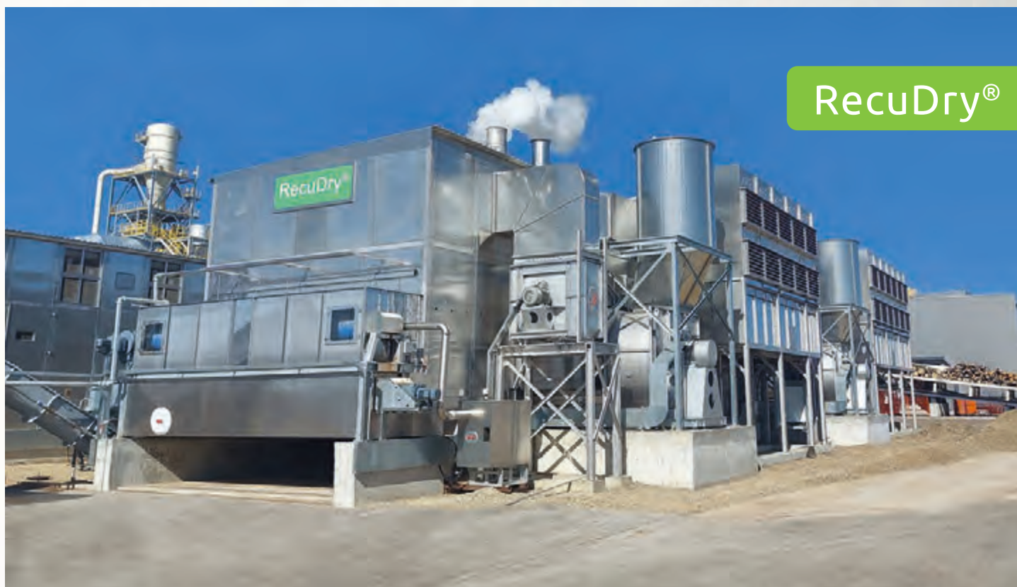
项目地：JSC, VMG Klaipeda, 立陶宛 | 型号：BTU RecuDry 1/6200-34.5 | 安装年份：2021 干燥物料：木屑 | 出料能力：约14.0吨/小时 | 降水区间：47% - 2%湿度
