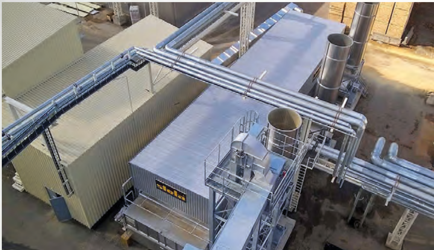
项目地：Mayr-Melnhof Holz, 俄罗斯 | 型号：BT 1/6200-27 | 安装年份：2017 干燥物料：木屑 | 出料能力：约9.0吨/小时 | 降水区间：50% - 10%湿度
