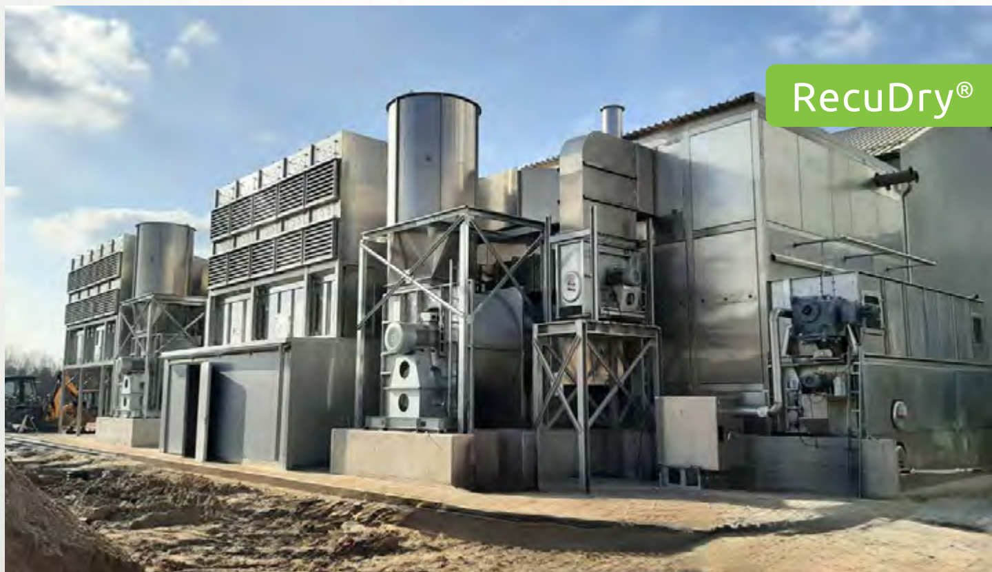
项目地: Biomasa Partner 波兰 | 型号: BTU RecuDry 1/6200-33 | 安装年份: 2023 干燥物料: 木屑 | 出料能力: 约7.7吨/小时 | 降水区间: 50% - 10%湿度
