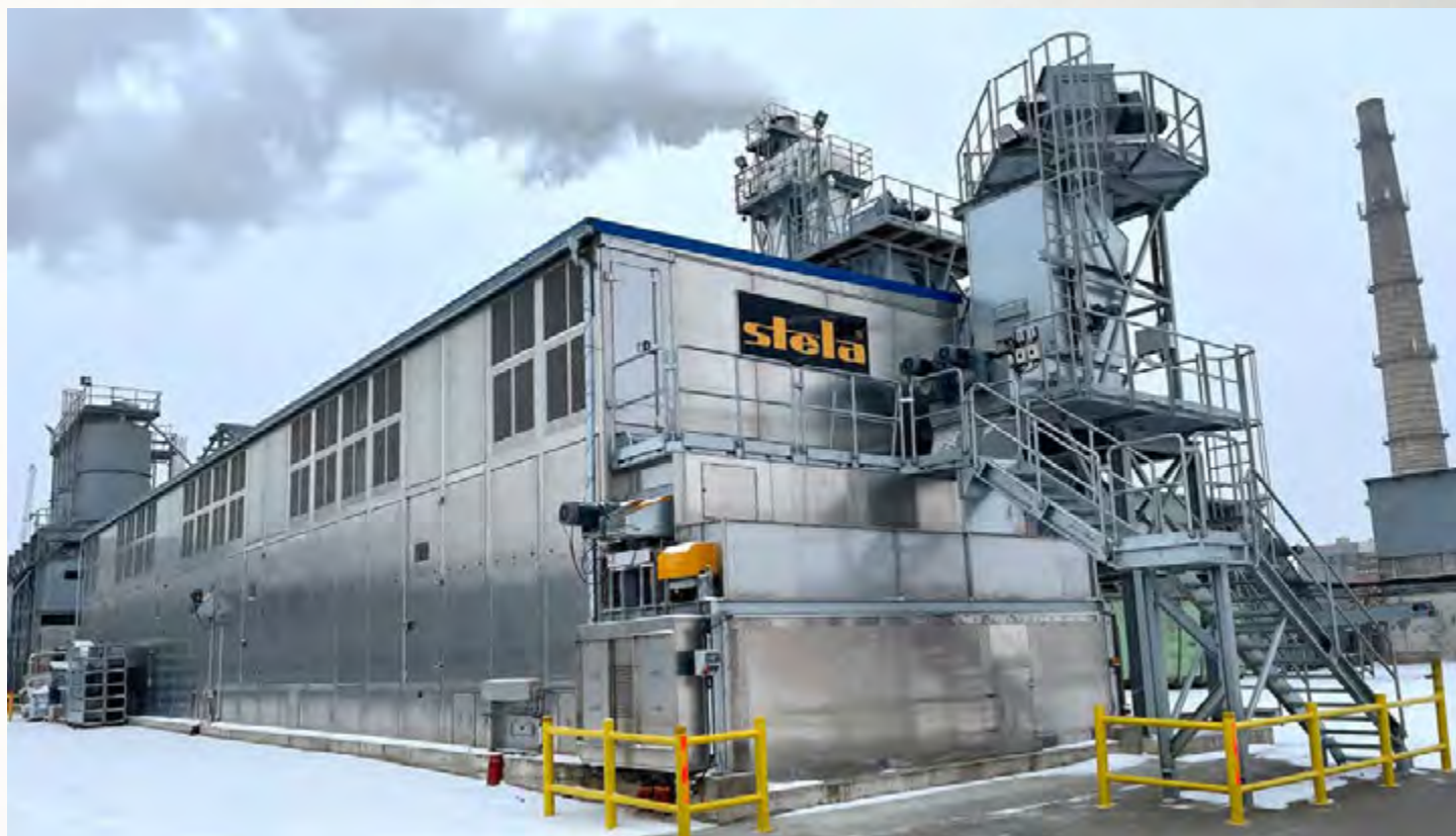
项目地：UAB Graanul Invest, 立陶宛 | 型号：BTU 1/6200-36 | 安装年份：2022 干燥物料：木屑 | 出料能力：约20.5吨/小时 | 降水区间：45% - 8%湿度
